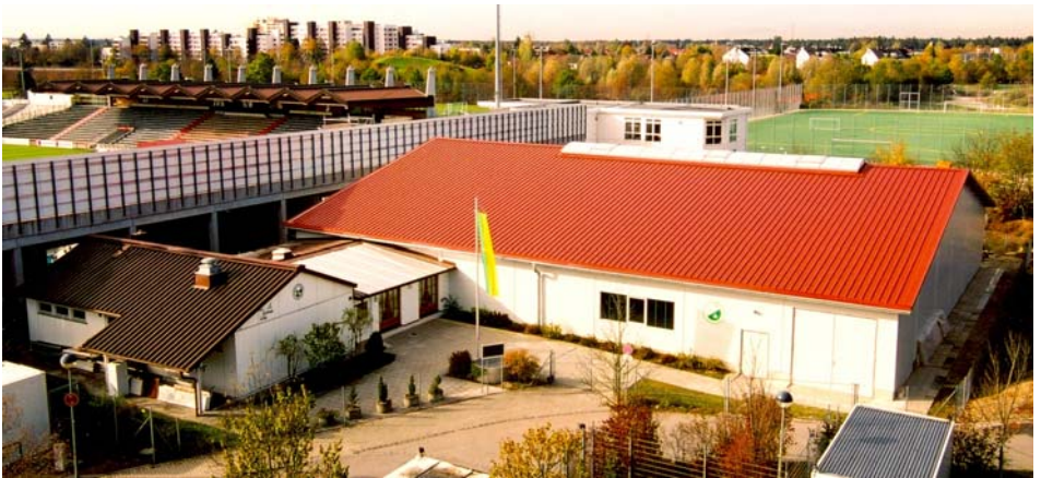
Die fertige Halle mit Vereinsheim
